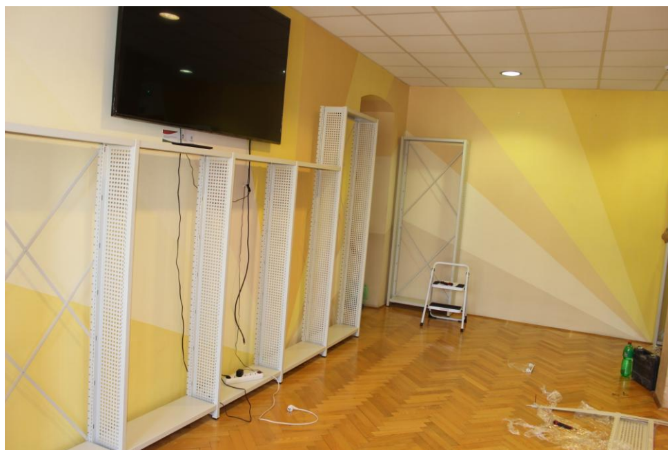
Montaža polica na dječjem odjelu
